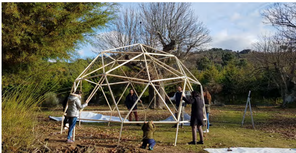
Fig. 12 Cúpula geodésica para laboratório móvel na natureza e a ser utilizado como estrutura para projecção de vídeo imersivo (desenvolvimento em curso, iniciado em Janeiro de 2019).
